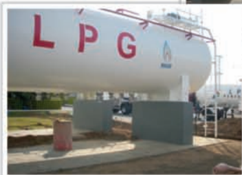
Tanki LPG 30 Ton Project SPPBE Pertamina Madiun
