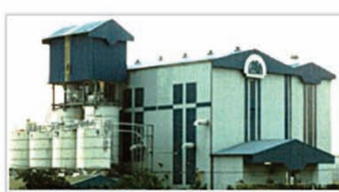
PROJECT OMYA - CaCo3 Tank
